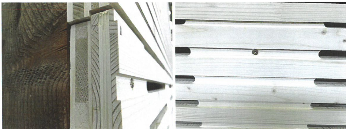
Abb. 6 - 7: Wandverkleidungsmuster-Teil mit der Paneel-Variante „Suzanna“ (ge- schlitzt): konstruktive Details; Prüfung am 18.05.2017
