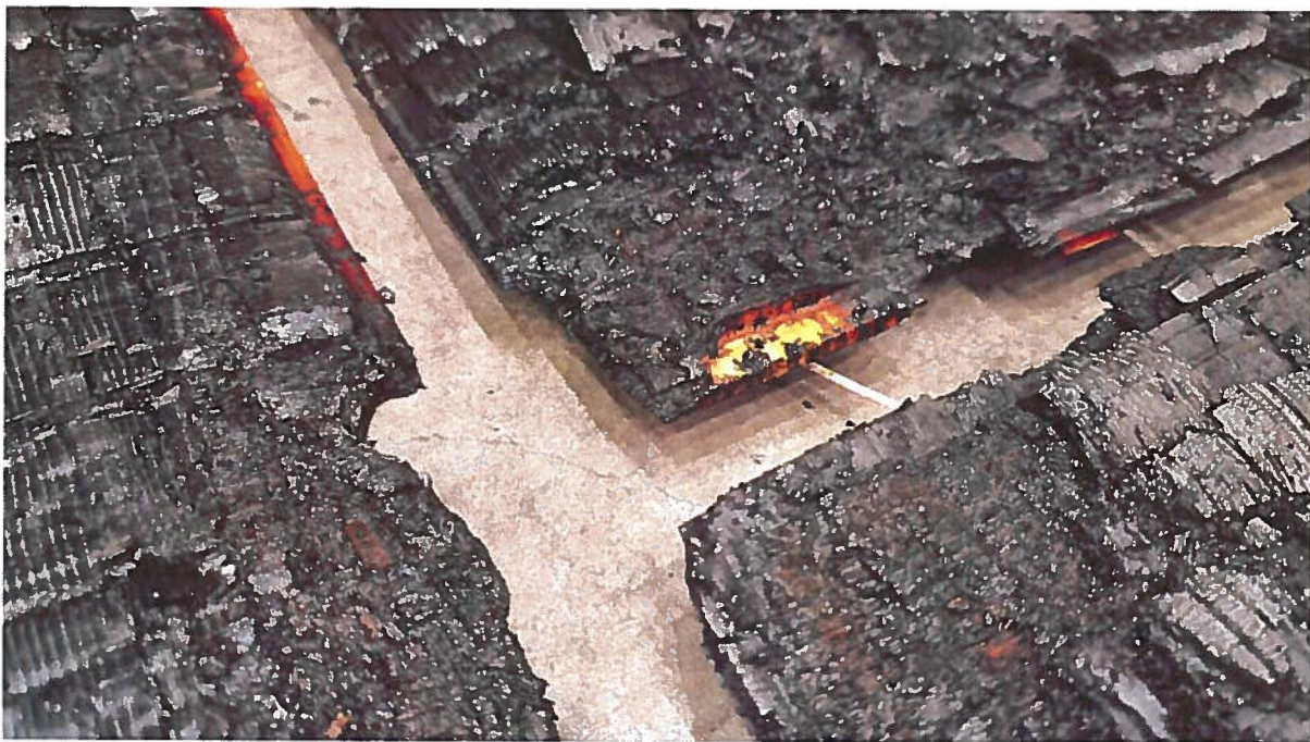
Obr. 12 Detail styku tří částí SWP EASY tloušťky 19 mm, po zkoušce v místě osazeného TC
